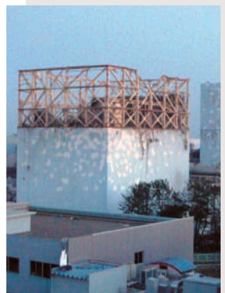
水素爆発後の東電福島第一原発1号機 (平成23年3月12日 東京電力提供)
