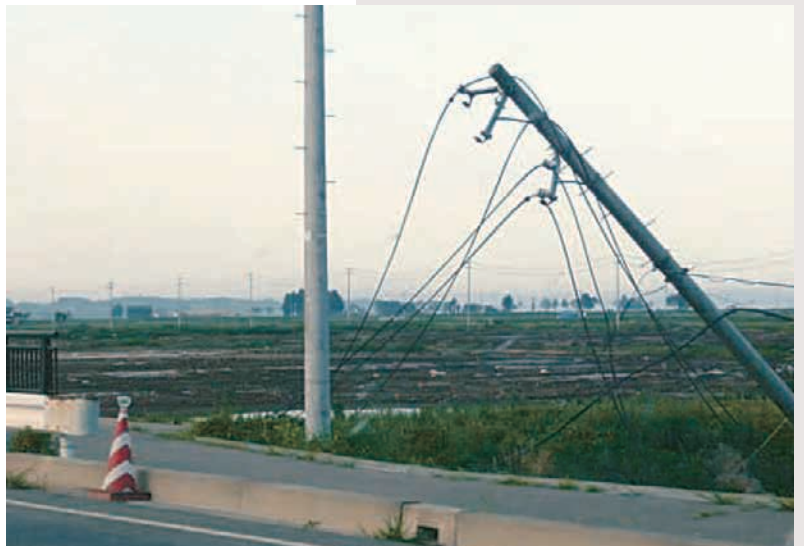
津波で倒壊した通信回線電柱（JAそうま管内）
