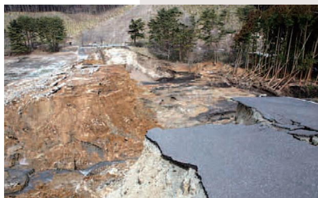
決壊した藤沼湖の堤(須賀川市)
