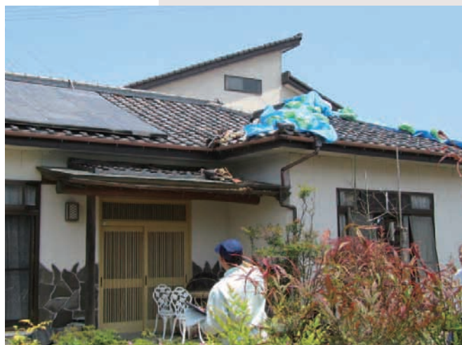
被害状況を調べる共済損害調査員
