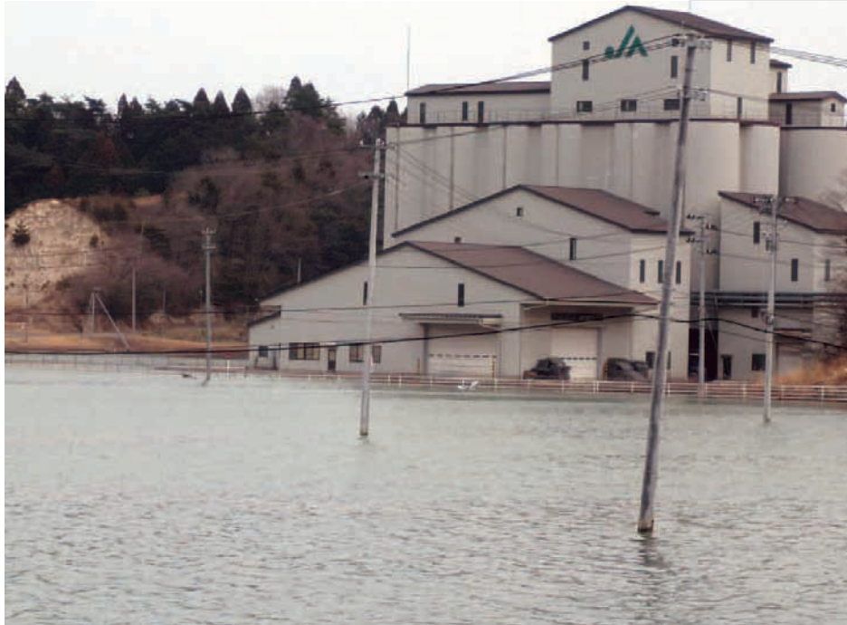
水に浸かったJAそうま小高ントリーエレベーター
