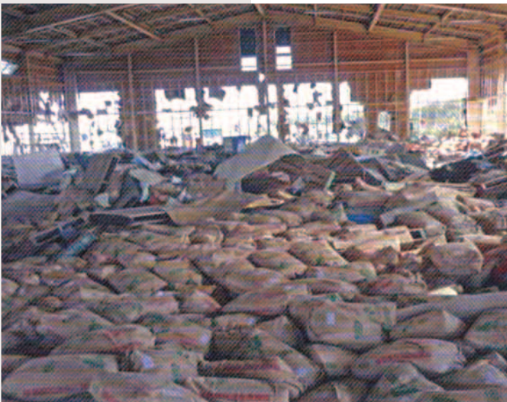
津波の来襲をまともに受けた日通の相馬港倉庫
