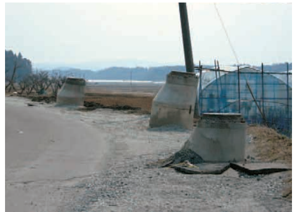
突き出したマンホール(JA東西しらかわ管内)
