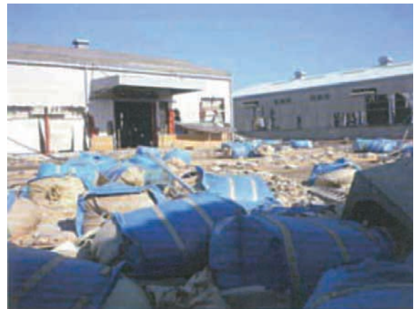
浸水した日通の倉庫(相馬港)
