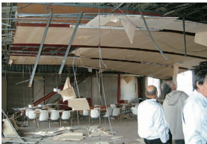
崩落したJA会議室(JA東西しらかわ矢吹支店)
