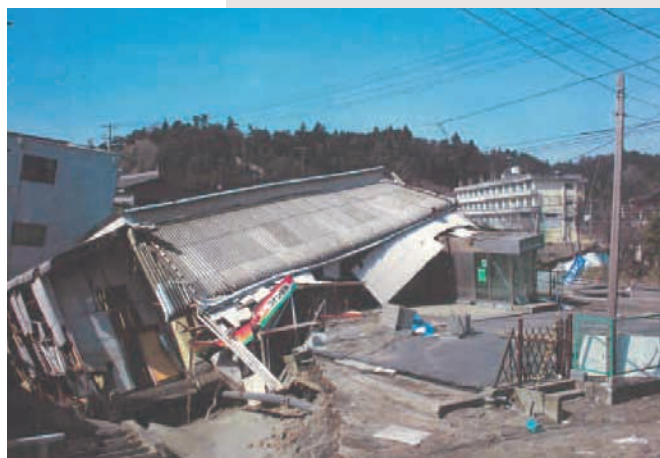
津波により倒壊した倉庫(JAいわき中部管内)
