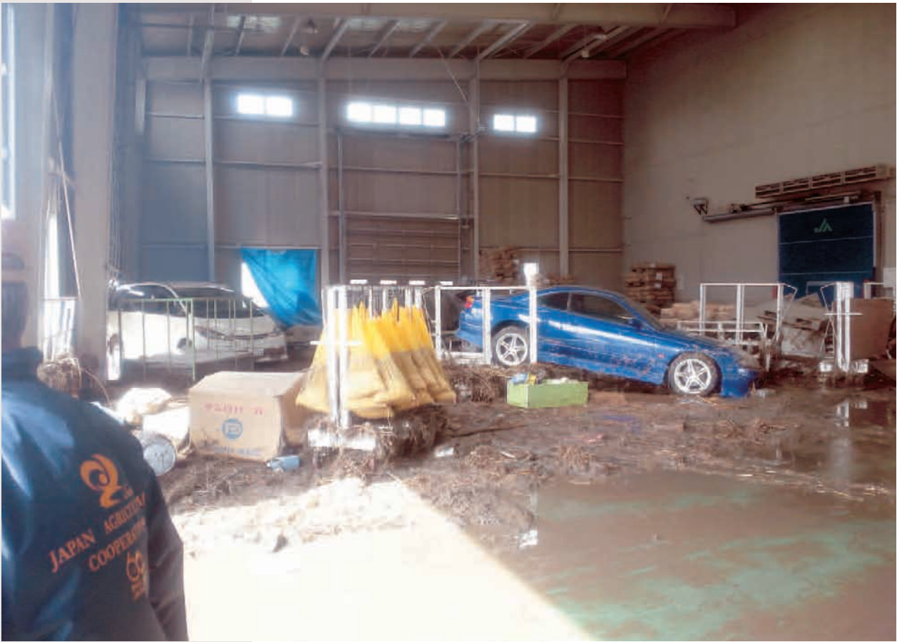
津波で流された自動車がシャッターを破って低温倉庫に流入 (JAそうま新地総合支店管内)
