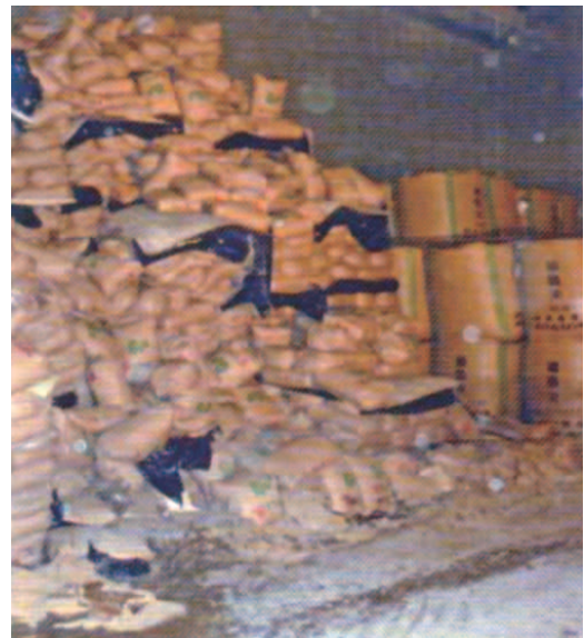
津波の被害を受けた低温倉庫 (JAそうま新地総合支店管内)
