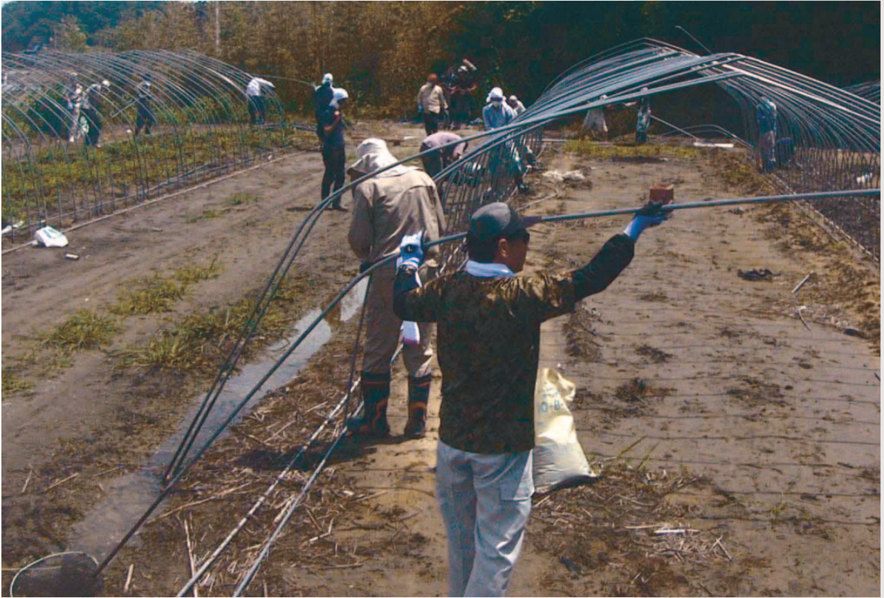
津波により被害のあったパイプハウスの撤去作業を行うJAグループ福島の職員(JAそうま管内)
